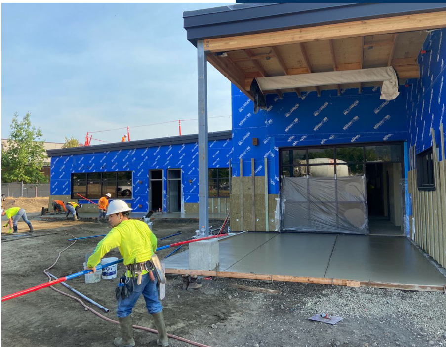
EXTERIOR SITE CONCRETE POUR
